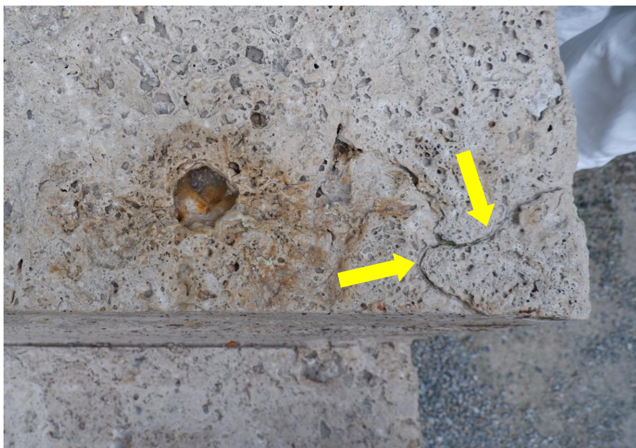
Imagini din anul 2021 cu banca sud, spre vest, partea superioară, detalii cu prezența mortarului folosit pentru lipirea fragmentului de travertin din bancă
