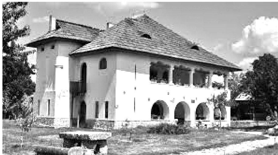
Casa Tătărescu de la Poiana fostă Carabatescu reconstruită în muzeul de la Curtișoara
